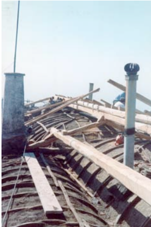
Vista dall'esterno dei DAMMUSI scoperchiati durante la ristrutturazione.
