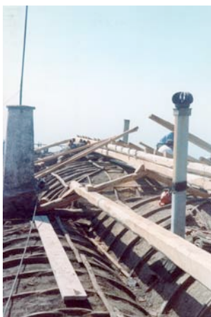
Vista dall'esterno dei Dammusi scoperti durante la ristrutturazione.
